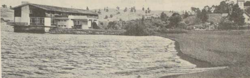
Las continuas descargas de aguas servidas, especialmente de Puerto Montt y Puerto Varas, tienen totalmente contaminado el lago Llanquihue. La Municipalidad de Puerto Varas está estudiando un proyecto para solucionar el problema.
