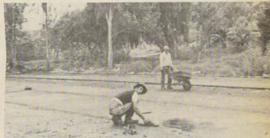
Trabajos de reparación de la cancha de básquetbol del complejo deportivo del Parque Pedro de Valdivia, en La Serena.
