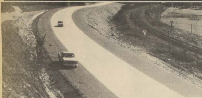
Se estima que en 1984 las principales rutas del país estarán en buenas condiciones para el usuario. Reparaciones menores y repavimentación se ejecutan en la actualidad, para conseguir ese objetivo.
