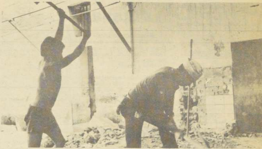
Dentro de 90 días la Cárcel Pública contará con un nuevo patio habilitado especialmente para el bienestar de las 1.800 personas reclusas. En la fotografía, parte del intenso trabajo que se realiza.
