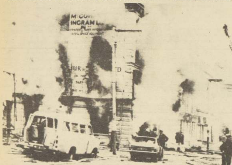
Bomberos tratan de dominar un rebelde incendio en un edificio de la calle Musgrave, en el centro de Belfast, que se originó con el estallido de una bomba, puesta en un camión estacionado frente al inmueble (Radiofoto UPI).
