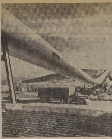
GIGANTESCO PLAN PARA EL TRANSPORTE DE METAL CLEVELAND, Estados Unidos. — Se proyecta gastar 210 millones de dólares en la construcción de este gigantesco sistema de transporte de mineral de hierro, entre el lago Erie y el río Ohio. Los cajones de mineral irán por un conducto metálico, instalado a siete metros sobre el nivel del suelo, lo que evitará obstruir el paso a los vehículos. — (Foto ACME).
