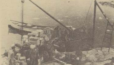
DESEMBARCO de abastecimientos y equipos.
