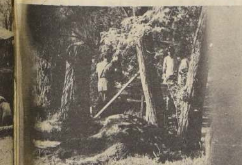
NO HAY MISTERIOS - Ya se puede decir que Iván Lepe tomó más "confianza". Registra un episodio netamente digno, donde en primer término se puede ver parte de ese movimiento de tierras que ejecuta la firma Constructora "M. P. Ltda." en el interior del Hogar "San José". Al fondo, funcionarios de Carabineros toman decla- raciones a otros obreros.
