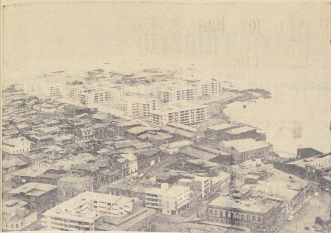
REMEDIACION "EL MORRO" (Iquique). 256 departamentos.
