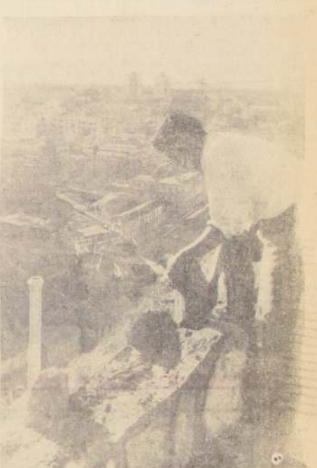
Un obrero levanta piedra a piedra un gran muro de contención, de los muros que se han debido construir en la parte alta de Valparaíso, para ir dando forma a la ciudad que se eleva hacia los cerros.
