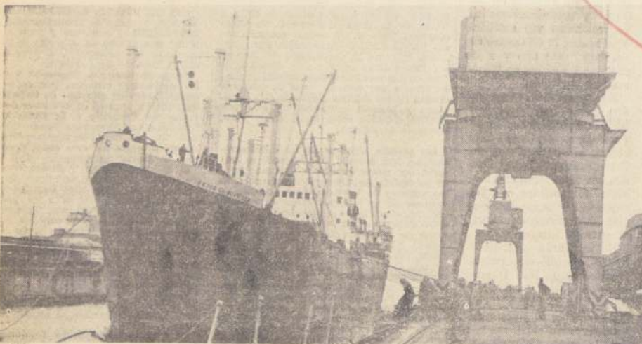
Personal en maniobra de entrada a dique.
