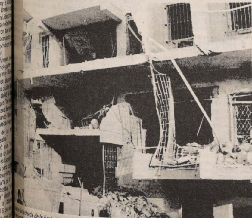
La fachada de la Embajada francesa en Trípoli, que resultó seriamente dañada durante el bombardeo norteamericano, sin que se registraran víctimas debido a que se encontraba al momento de ocurrido el ataque. (Reuter).
