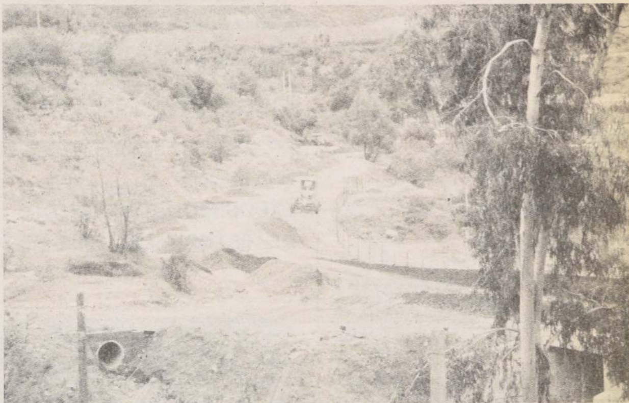
El camino de "El Melocotón" permitirá un más fácil acceso a San José de Maipo y las demás localidades que existen en la comuna, terminando
