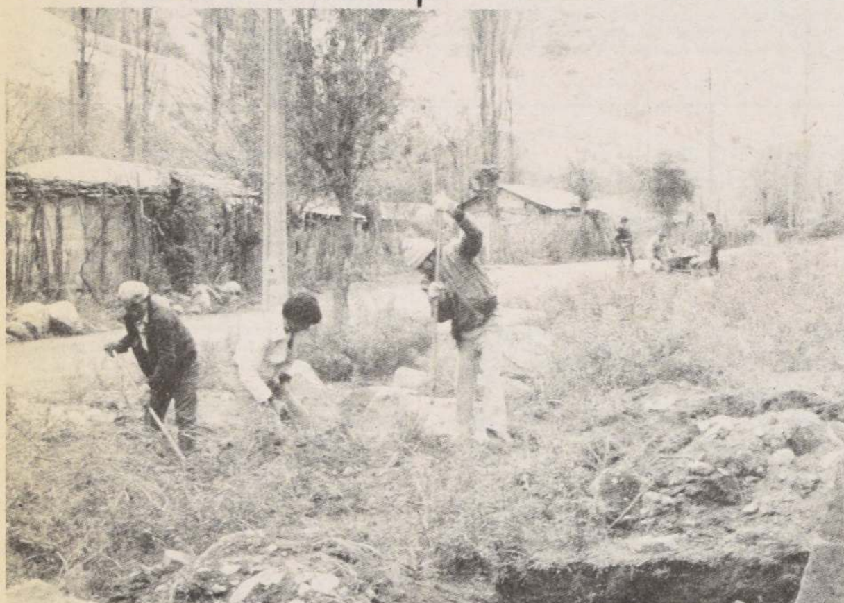
Activamente se trabaja en el despeje de los terrenos donde serán construidas las viviendas sociales que permitirán la solución del problema de la falta de
