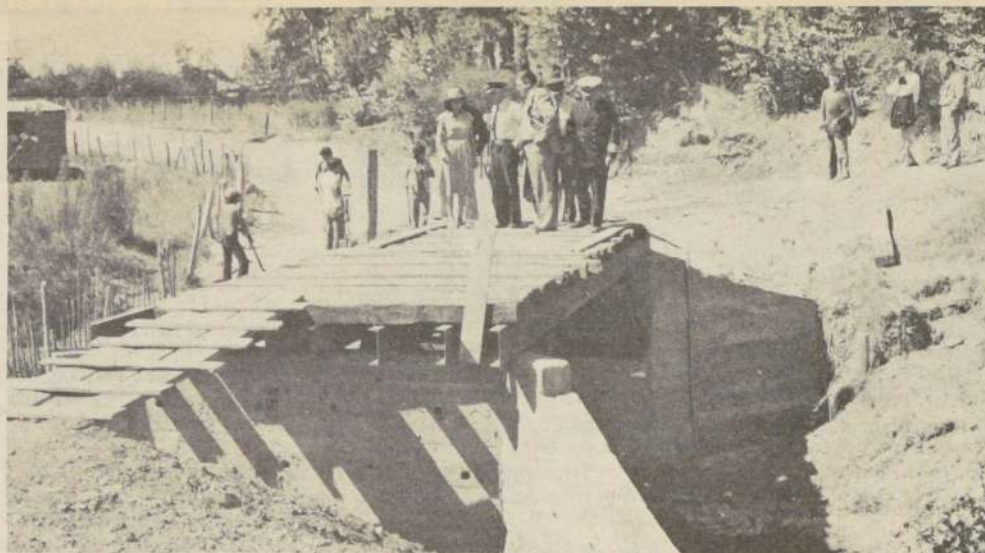
EL INTENDENTE DE LA QUINTA REGIÓN, vicealmirante Raúl López Silva, junto a autoridades comunales y regionales, observa el estado de construcción del nuevo puente El
