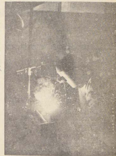
Un técnico en la materia realiza trabajos de soldadura autogena en una de las secciones de la Maestranza.
