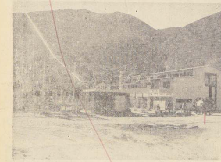
En su plan de dar energía eléctrica a todo el país, la ENDESA ha establecido a lo largo de la República diversas centrales, una de las cuales está en el extremo norte, la de Chapiquiña, de la cual damos una vista general. A la izquierda se ve una parte de la tubería, cuya extensión total es de 4.200 metros.
