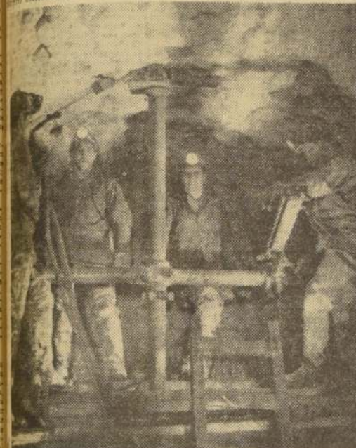
PERFORANDO LA ROCA VIVA. — Premunidos, convenientemente cascos, lamparillas y otros elementos de protección, obreros "El Teniente", perforan la roca viva por medio de modernas y pesadas maquinarias.
