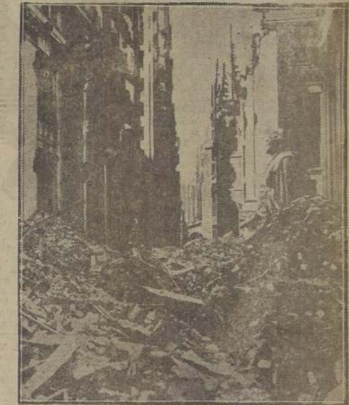
Fotografías de la calle Wall Street que ilustran los probables efectos de un bombardeo del sector financiero de Nueva York. Los escombros pueden obstruir completamente las estrechas calles de esta parte de la ciudad, e impedir el acceso de las brigadas de salvamento. Los incendios en estas circunstancias no podrían ser dominados. La fotografía superior, antes del bombardeo; la inferior, después, permitiendo formarse una idea de lo que sería un ataque atómico a Nueva York.
