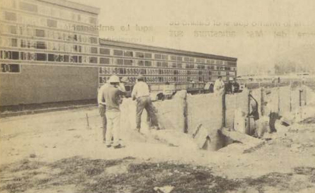
El moderno TOTALIZADOR PALMEÑO alza sus líneas mientras los obreros destruyen los firmes cimientos de la antigua pizarra.
