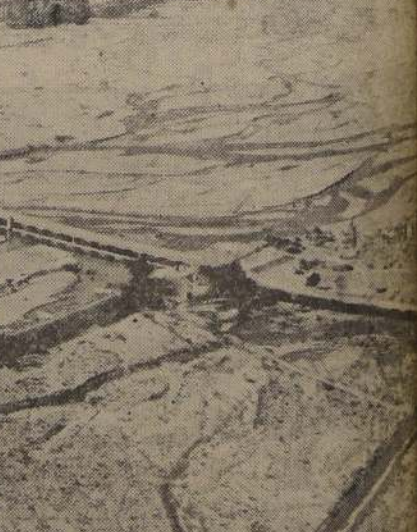
Fotografía aérea del Dique "Cipolletti" (Luján de Cuyo, Mendoza), tomado desde la margen derecha del río Mendoza. Puede apreciarse la defensa marginal de aguas arriba y el puente carretero que forma parte de la obra. Igualmente, hacia la margen izquierda, alcanza a verse la entrada del Sifón del canal. Margen Derecha y más lejos, canal, Margen Izquierda, y la cámara desarenadora de la misma.
