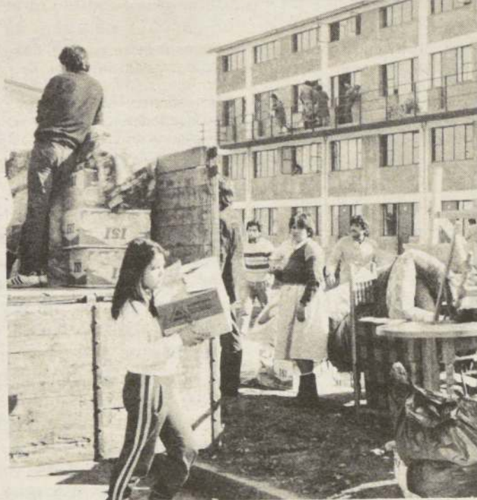
Las familias beneficiadas con casas definitivas en La Florida, descargan sus enseres. De albergados se convierten en legítimos propietarios de sus viviendas.
