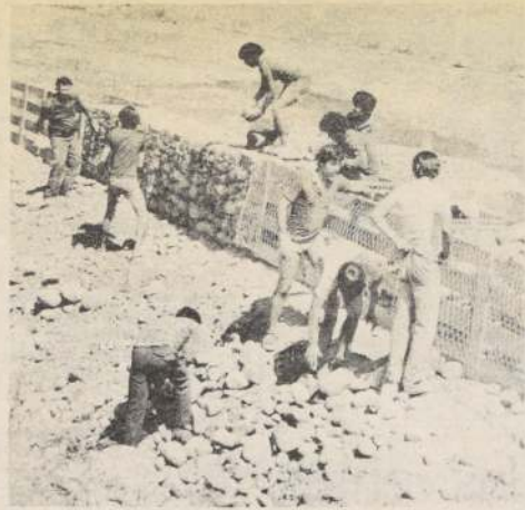
Trabajadores del POJH laboran en la construcción de defensas en el Mapocho.
