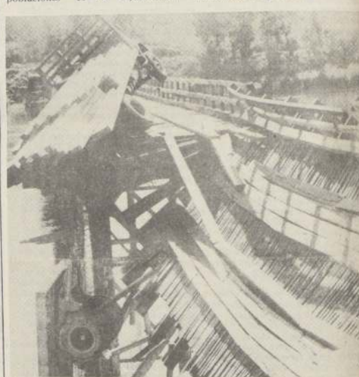
Un camión maderero con exceso de carga desplomó un tramo del puente sobre el río Itata, recientemente. En el mismo peligro se encuentra ahora el puente Escalones, en la costa curicana.
