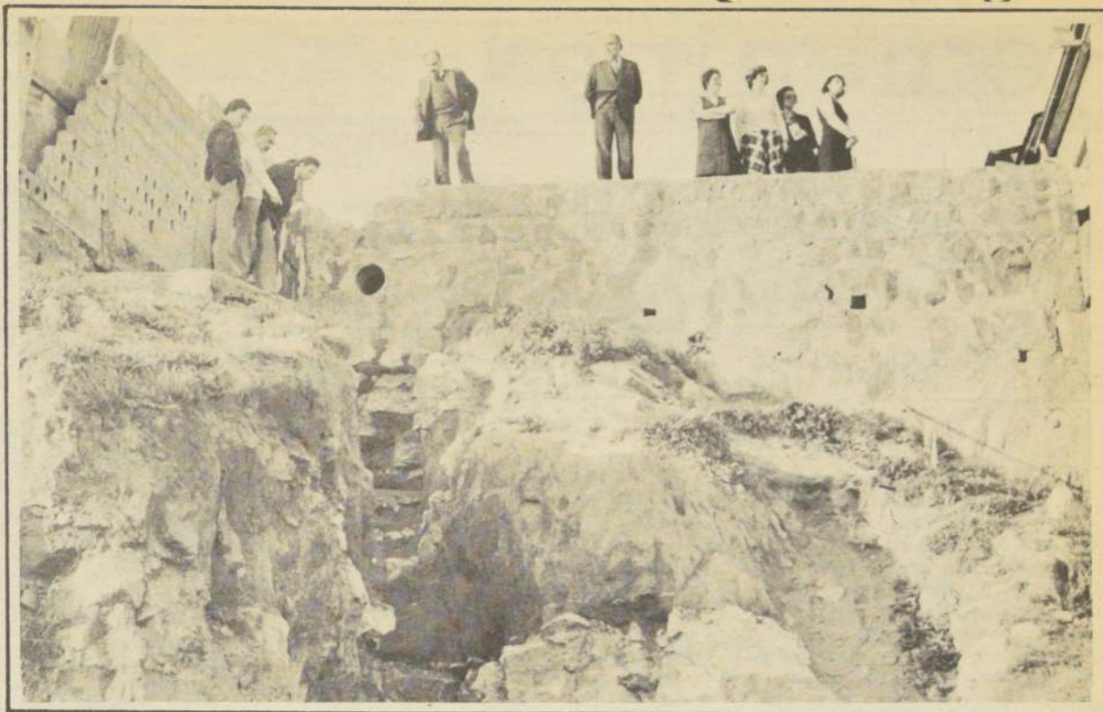
EL ALCALDE BARTOLUCCI observa la Quebrada de San Luis en calle Irene Morales, del Cerro Placeres, donde las lluvias causaron la intensa erosión que muestra la foto, al arrastrar la tierra.
