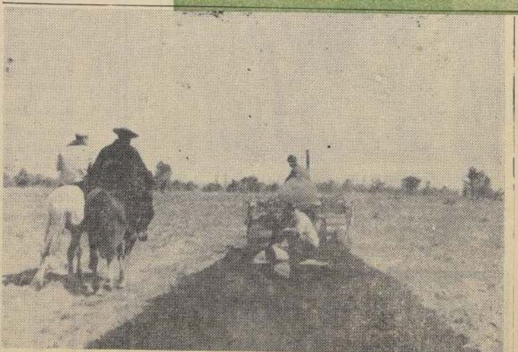
La implantación y adaptación de nuevas maquinarias al laboreo del campo, constituye una de las metas más importantes del programa ampliado de Asistencia Técnica de las Naciones Unidas. En el grabado, se muestra un arado acequidor arrastrado por un tractor oruga.
