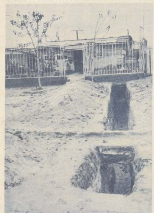
Esta es una de las profundas zanjias abiertas por los vecinos de la Villa Manuel Rodríguez, en calle Territorio Antártico 6230.
