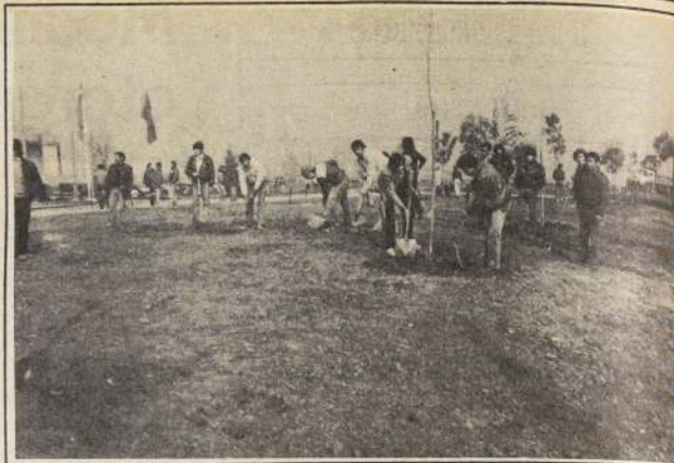
Construcción de áreas verdes, mantención y mejoras y sedes comunitarias, son algunas de las faenas que darán trabajo a más de 800 jefes de familia sambernardinos a través de las nuevas inversiones aprobadas.
