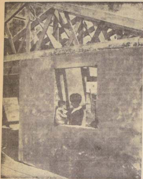
Gracias a las máquinas elaboradoras de bloques de suelo de cemento, otorgadas por el Gobierno de Estados Unidos dentro del programa de la Alianza para el Progreso, pobladores de "Nueva Palena", en Peñalolén, han podido autoconstruir sus viviendas, en un plazo relativamente breve. El grabado muestra a una madre junto a su pequeño hijo, en el interior de estas casas levantadas con esfuerzo y sacrificio por sus modestos propietarios.
