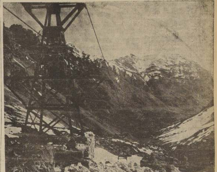
Un aspecto de la línea de andariveles de 18 kilómetros de longitud, que transporta el yeso desde los yacimientos hasta la Planta Elaboradora, en plena cordillera
