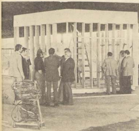
Avanzan los trabajos en el Pabellón N° 10 de FISA - 74, que corresponde a las empresas FENSA - MADEMSA, que junto a otras industrias mostrarán su producción en artefactos de la línea blanca
