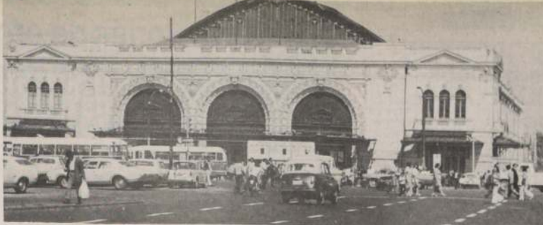
Una inversión aproximada de un millón de dólares costará la restauración de la Estación Mapocho de Ferrocarriles, que comprende reparaciones de los sectores laterales, demolición de edificios internos y habilitación de áreas verdes. En esta labor trabajan 60 personas del POJH, quienes remodelarán el 75 por ciento de la fachada exterior del inmueble, a la vez que construirán nuevas boleterías. Al mismo tiempo, sus interiores se dotarán de áreas comerciales y dependencias para sucursales de bancos y servicios.
