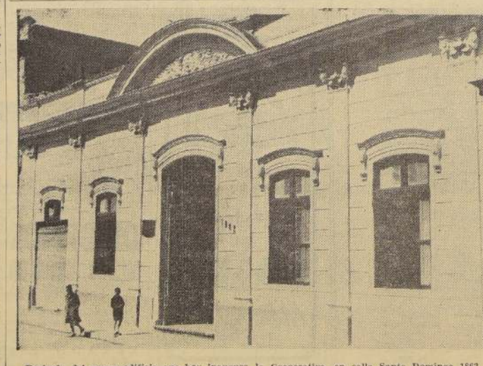
Fachada del nuevo edificio que hoy inaugura la Cooperativa, en calle Santo Domingo 1862.
