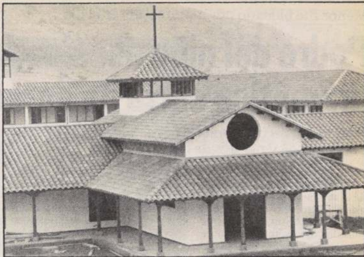
El nuevo monasterio de las Carmelitas Descalzas, en la localidad de Auco, en cuyo complejo arquitectónico se construirá el santuario de Sor Teresa de Los Andes que deberá estar terminado el 12 de abril del próximo año.
