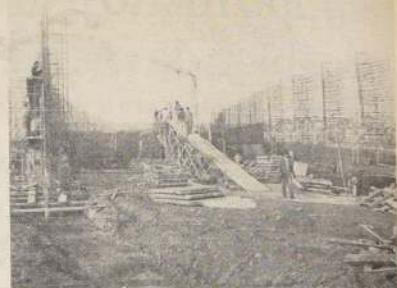
Estado actual de construcción del terraplen de acero y concreto que dará acceso al nuevo puente de Los Mayos, de 15 metros de ancho y tres pistas. Tendrá 150 metros de longitud y irá montado sobre 41 pilares. En el lugar habrá una rotonda para facilitar el ingreso y la salida de los vehículos.
