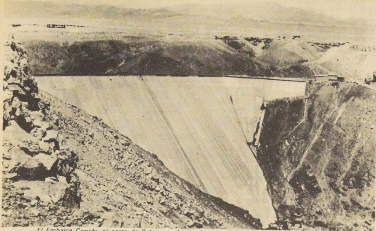
El Embalse Conchi, al norte de Calama, sobre el Río Loa, tiene una capacidad de 22 millones de m 3 y un muro de contención de 70 mts. de alto. Su objetivo fundamental es abastecer del vital elemento a la industria, la minería, agua potable y riego.
