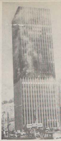
Incendio de la Torre Santa María, ejemplo que refleja las deficiencias de los edificios de altura para controlar la magnitud y consecuencias del fuego.
