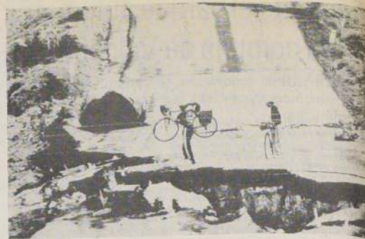
PACIFICA, (California).— Dos jóvenes ciclistas deben cargar sus vehículos para pasar la carretera de alta velocidad, en el lugar denominado "Resbalón del Diablo", la que resultó destruida por los recientes temporales. (Radiofoto UPI).
