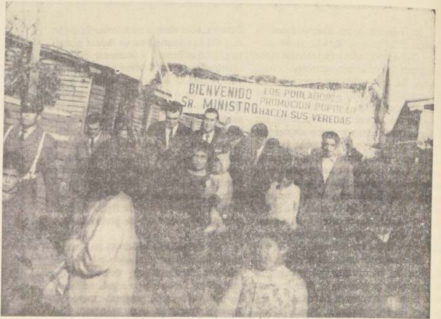
Entusiásticamente recibieron al Ministro de Obras, Sergio Ossa, los pobladores de la provincia de Curicó. El grabado registra la visita inspectiva que dicho Secretario de Estado efectuó a la población "Sol de Septiembre", que se levanta en la capital de esa provincia.
