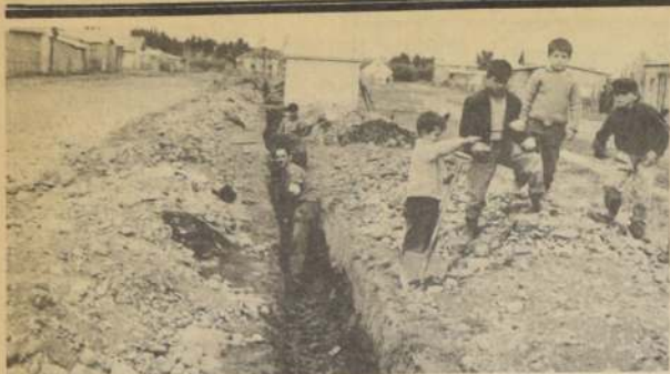
En diversas comunas se están instalando redes de alcantarillado, como parte del programa de Gobierno destinado a crear nuevas fuentes de trabajo.
