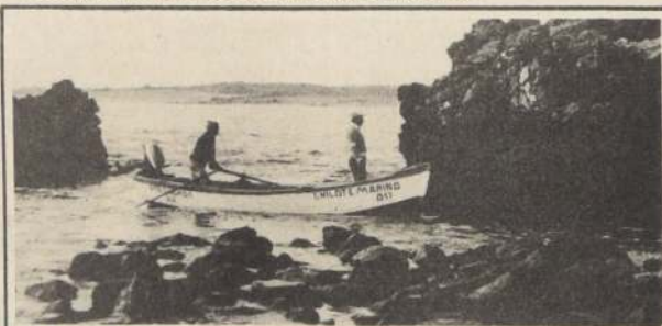
Personal militar dinamitó y cortó la roca, construyendo una pasadita para que los botes puedan ingresar al nuevo varadero habilitado en Caleta Los Choros, en el litoral de Coquimbo.
