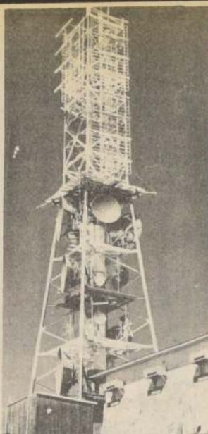
La torre de ENTEL, que permite las comunicaciones desde Santiago con el resto del país y el mundo.
