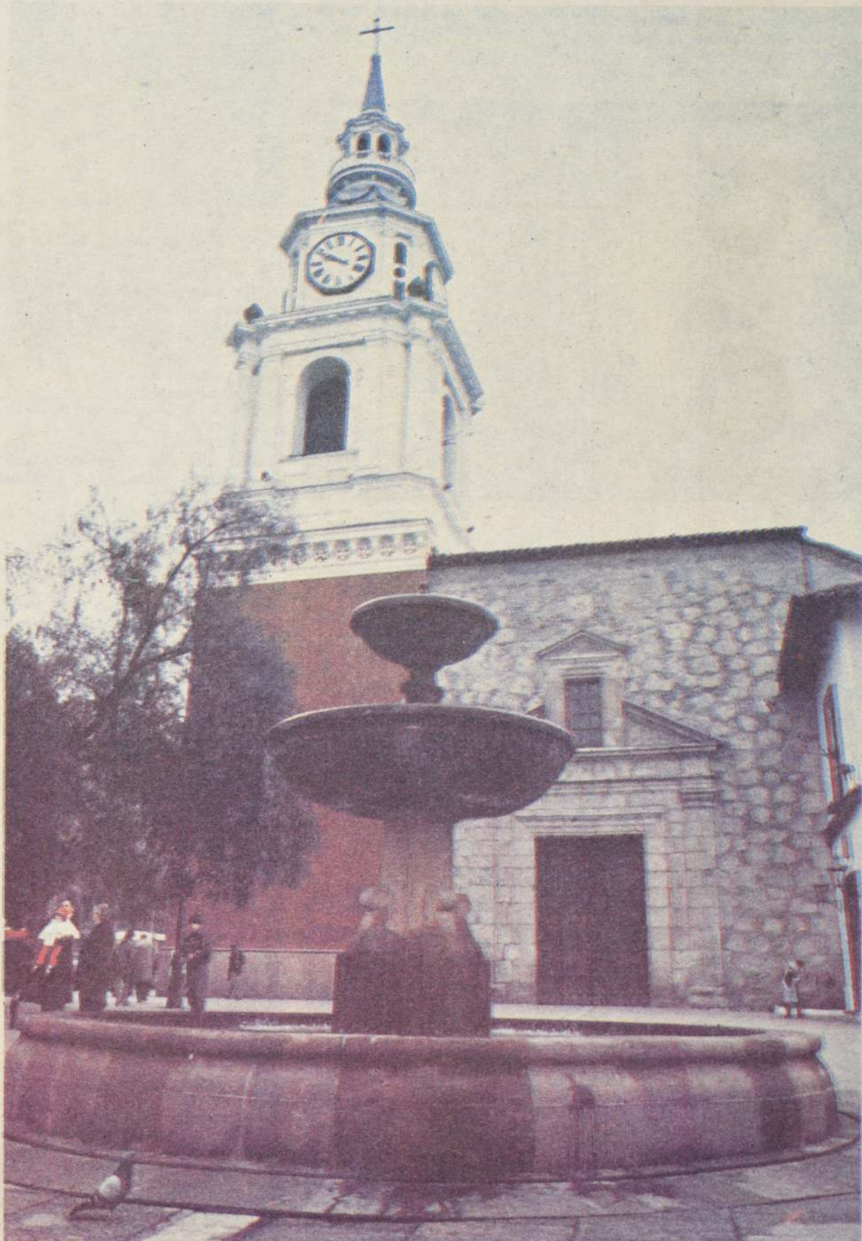
La torre actual de la iglesia, para muchos punto de referencia, obra de Fermín Vivaceta.
