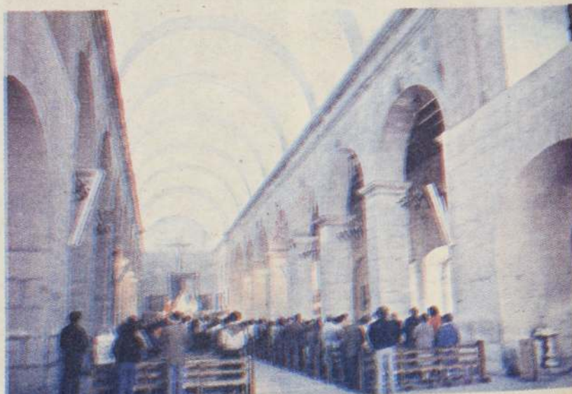
Gracias al incendio pueden apreciarse los muros de piedra blanca de sillera.
