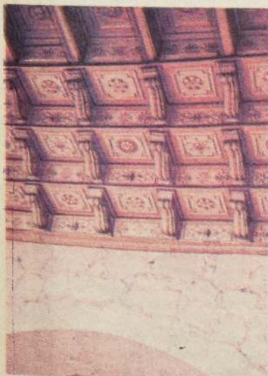
El artesonado o techo labrado es uno de los detalles importantes de San Francisco.
