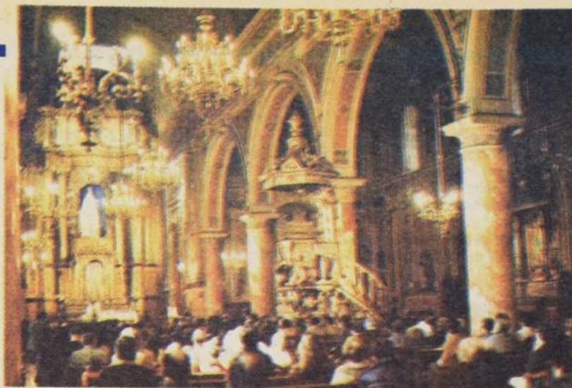
La Merced tiene tres naves en su interior separadas por arquería de medio punto y columnas de piedra.
