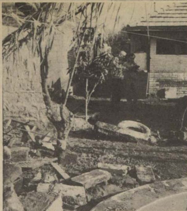
El ingeniero agrónomo Ricardo Bravo Figueroa cuenta a LA NACIÓN los daños provocados por el desbordamiento del río Mapocho en la madrugada del domingo último. Su casa ubicada en Vitacura, frente al club de equitación San Cristóbal, quedó sumergida en el lodo y con patio "común" con los demás vecinos.
