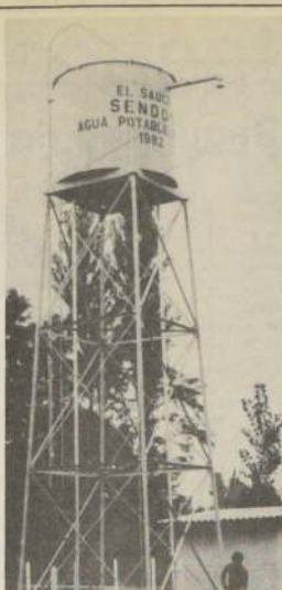
Moderno sistema, que abastecerá de agua potable las casas de los sectores rurales en El Sauce, cerca de Concepción, en la VIII Región.
