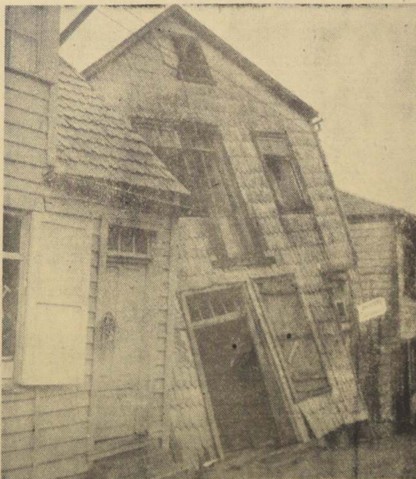
DEBERA SER DEMOLIDA.— Más de un caso como éste se registró en Puerto Montt. Las casas livianas, de madera, bailaron remecidas por el violentísimo temblor, y cuando el movimiento de tierra se detuvo, quedaron así, como lo muestra el grabado, tumbadas, como dándose mutuo apoyo para no caer definitivamente. Uno de los muros parece resistirse a abandonar lo que hasta ayer constituyó su casa.
