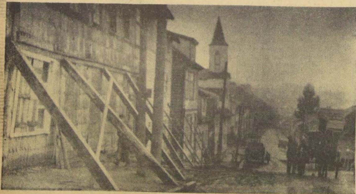
PUNTALES EN LAS PAREDES. — En contados minutos la fisonomía de Puerto Montt sufrió súbita transformación. Las pocas casas que lograron resistir el violento impacto del terremoto, se inclinaron peligrosamente. Debieron ser reforzadas, como lo muestra el grabado, para impedir que se fueran al suelo. Esta calle, que tiene el sello inconfundible de los puertos, sufrió como muchas los efectos de la enloquecida danza de la tierra. Bajo los soportes, que por un milagro parecen sostenerla, un muchacho cruza desprendidamente, mientras una familia carga un pequeño bulto pertenencias para llevarlas a un sitio más seguro.
