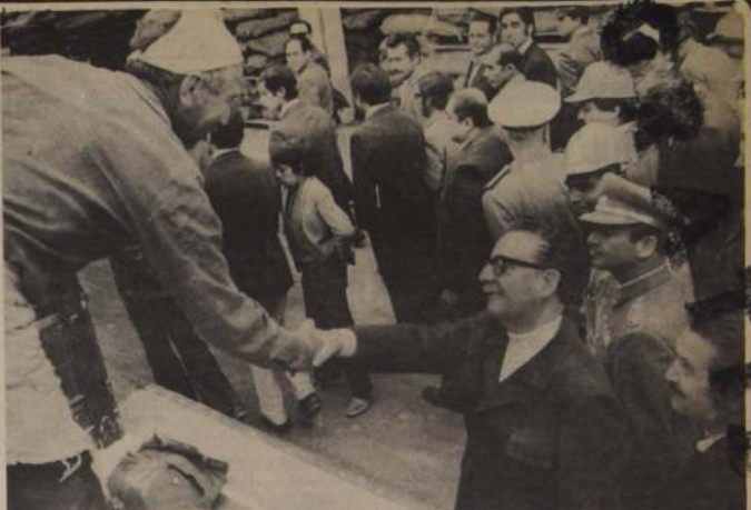
UNA VISITA A VALPARAISO realizó ayer el Presidente Allende, quien inspeccionó la planta industrial soviética de viviendas, las remodelaciones Almendral y José Manuel Balmaceda e inauguró diversas obras, rodeado del afecto de los trabajadores.
