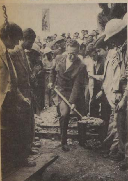
LA PRIMERA PIEDRA de la obra remodelación Estación Barón, puso ayer el Presidente Allende durante su visita a Valparaíso. En la foto, el "Jefe del Estado" en los instantes en que completa su "tarea" con una pesada palada de cemento.
