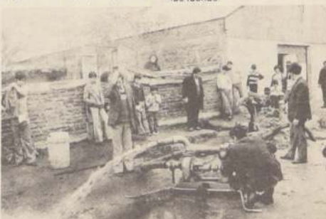
Persohal de Obras Sanitarias de Barrancas debió concurrir con una motobomba para extraer el agua de una zanja y reparar la cañería del agua potable, rota de una chuzazo, en el ardor del trabajo. Aparecen el capataz Luis Cajas y los maestros José Contreras, Rodrigo Lara, Ramón Vega, Luis Reyes y Romulo Muñoz. Los niños miran el chorro de agua que expelle la bomba.
