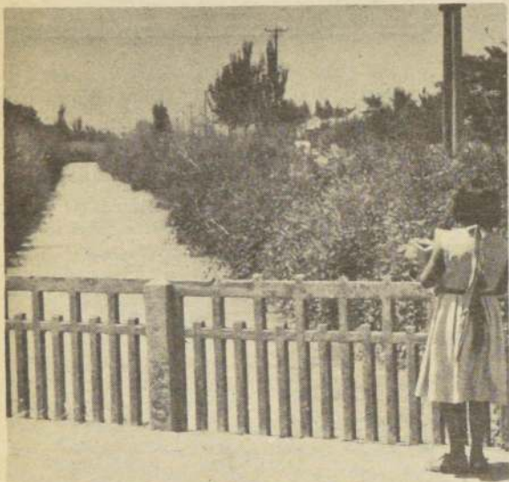
EL CANAL SAN CARLOS es un peligro para los transeúntes y un foco de infección para los barrios que atraviesa.
