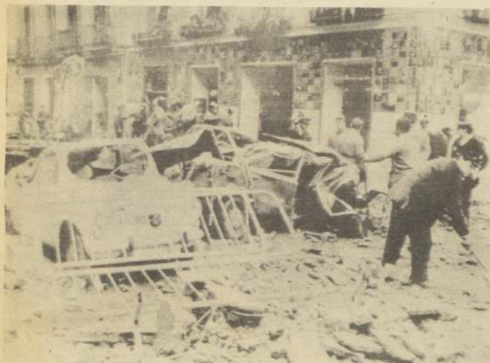
MADRID, España. Patrullas de rescate y bomberos buscan entre los escombros dejados por una explosión de gas que perforó una calle del centro comercial de esta capital, causando graves destrozos y la
