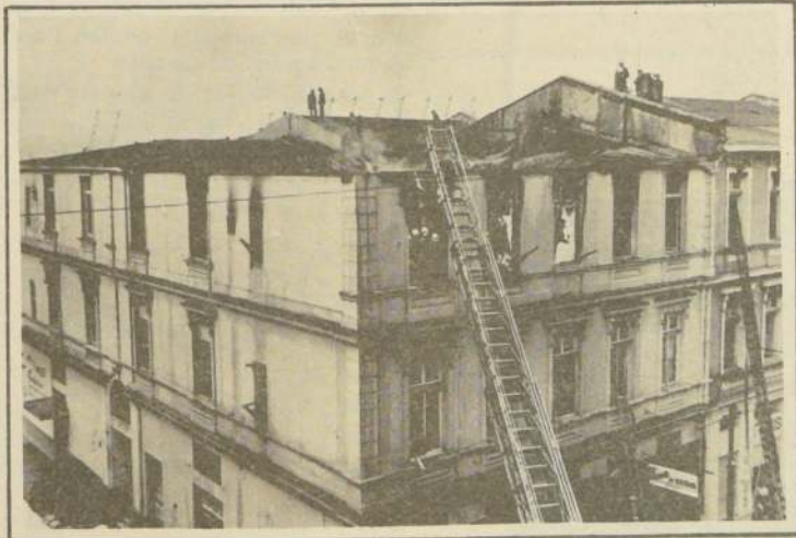
El tercer piso del inmueble ubicado en Clave con Blanco en Valparaíso, resultó completamente destruido por la acción del fuego.
