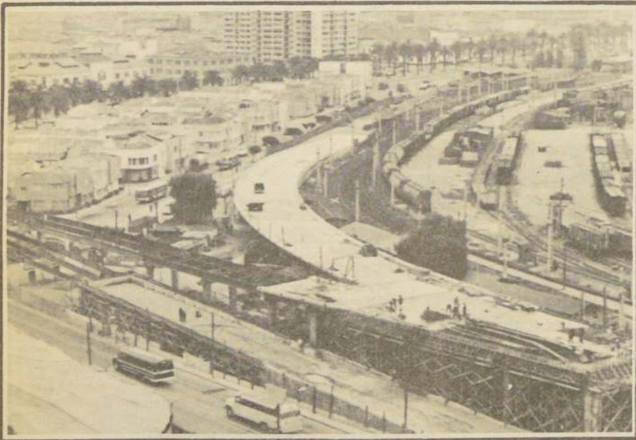
LA SUPERCARRETERA de seis pistas que unirá a Viña del Mar con Valparaíso llegará al nudo Barón, mostrado en la foto. Allí existen las vías elevadas que conectan con Avenida Errázuriz, a la derecha, y con Avenida Argentina, a la izquierda. Las autoridades de Vialidad, del SERVIU y de otros sectores interesados en la monumental obra, deberán decidir en breve si la conexión se hará al nivel de estas vías elevadas, o a ras de suelo, lo cual obligará a demoler estas costosas construcciones que quedaron inconclusas al ser suspendido el proyecto total de la vía elevada.
