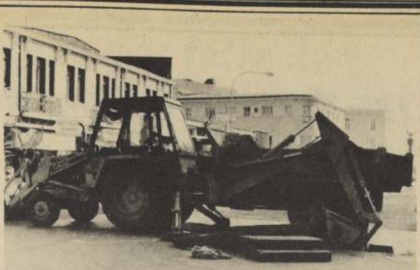
EXTRACCION DE ARENA DE CAUCES
