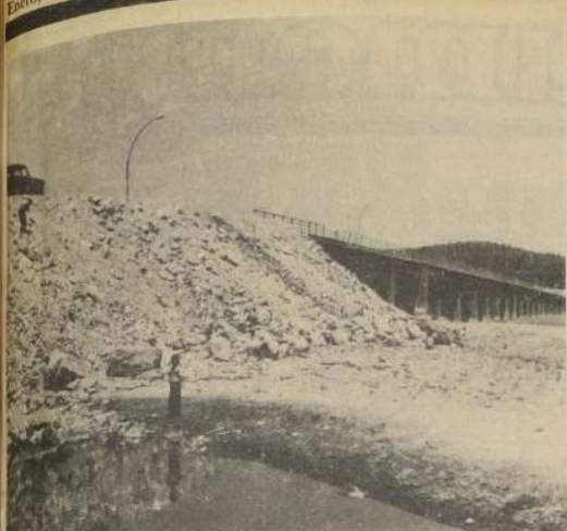
El puente viejo del río Bío Bío, donde se iniciaron los trabajos para la instalación de una vía elevada que posibilitará el acceso directo entre Concepción y San Pedro.
