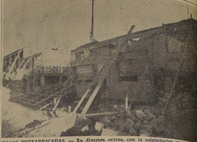
CASAS PREFABRICADAS. —En diversos cerros, con la colaboración amplia del pueblo que dirige el señor Leyton, se están erigiendo nuevas poblaciones obreras. En el grabado, un aspecto de la construcción de una serie de casitas para obreros en el Cerro Las Monjas. Son casas de madera, prefabricadas. Se estima que ayudarán a solucionar el grave problema de la habitación en el puerto.
