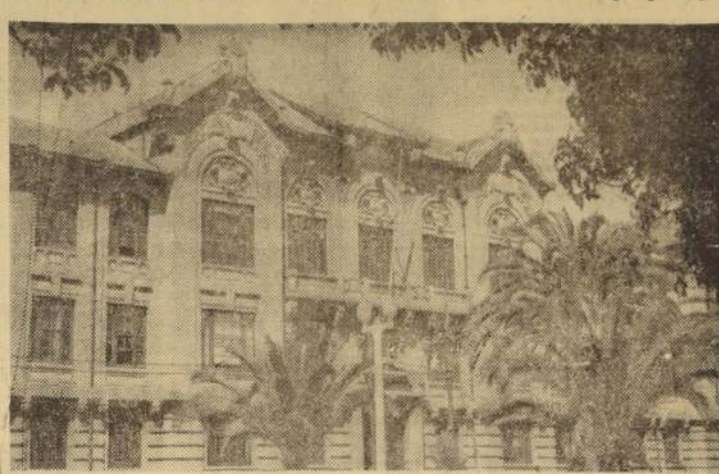
UNIVERSIDAD CATOLICA DE VALPARAISO. — En el grabado, se ve la fachada del edificio de la Universidad Católica de Valparaíso.
