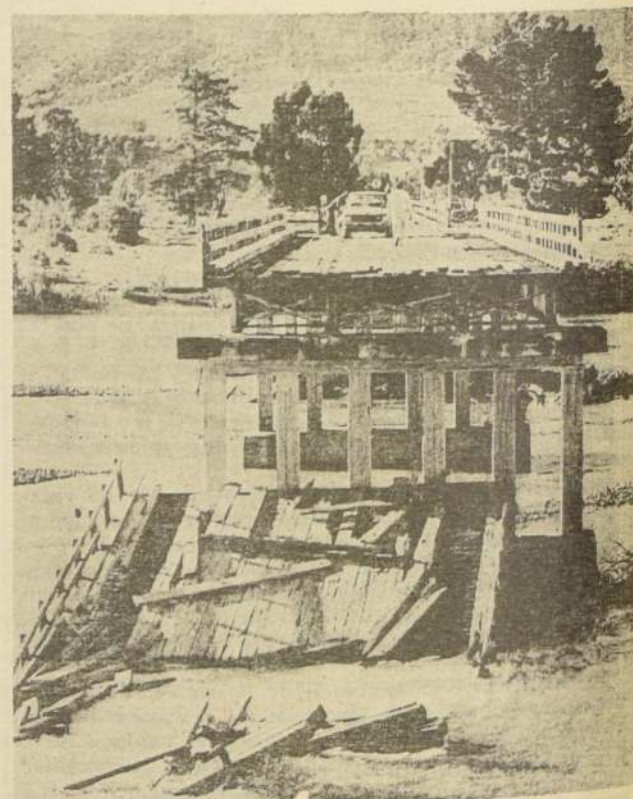
En este estado quedó el Puente Confluencia, al ser derribados sus tramos por la crecida del río el invierno pasado. Su reparación será terminada en 150 días.
