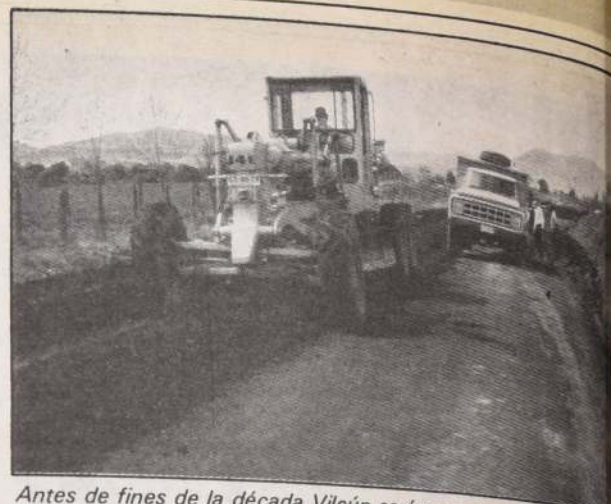
Antes de fines de la década Vilcún será cruzada del valle a la precordillera por una cinta asfáltica. En la fotografía, con maquinaria adecuada se iniciaron los trabajos preliminares a la pavimentación de 15 kilómetros de la ruta, entre Cajón y Vilcún.
