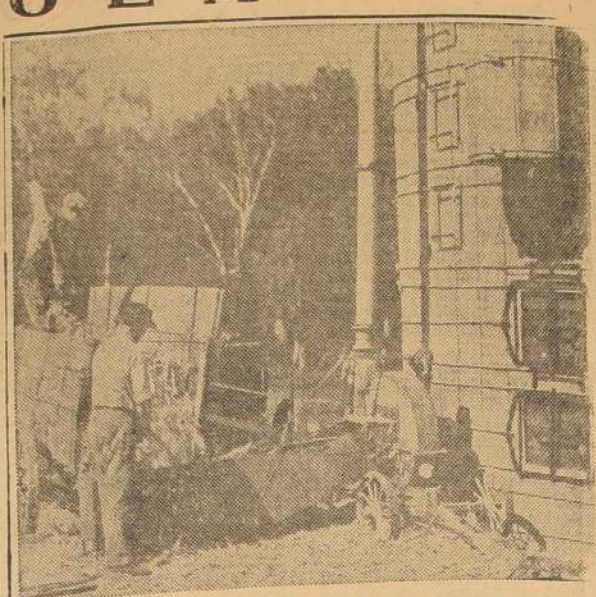
Ensilaje de maíz con equipo "Rowning" que recoge y corta la caña antes de cargarla en el carro en que se le conduce al silo.
