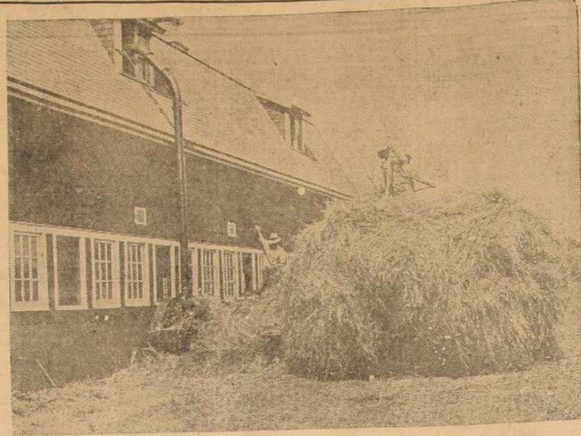
El heno picado, además de reducir considerablemente los desperdicios, ocupa menos espacio en el henil y se le manipula con mayor facilidad. Esta picadora de heno (Pepec, modelo K, actualizada por un tractor "Internacional") lo corta a razón de 7 toneladas por hora.
